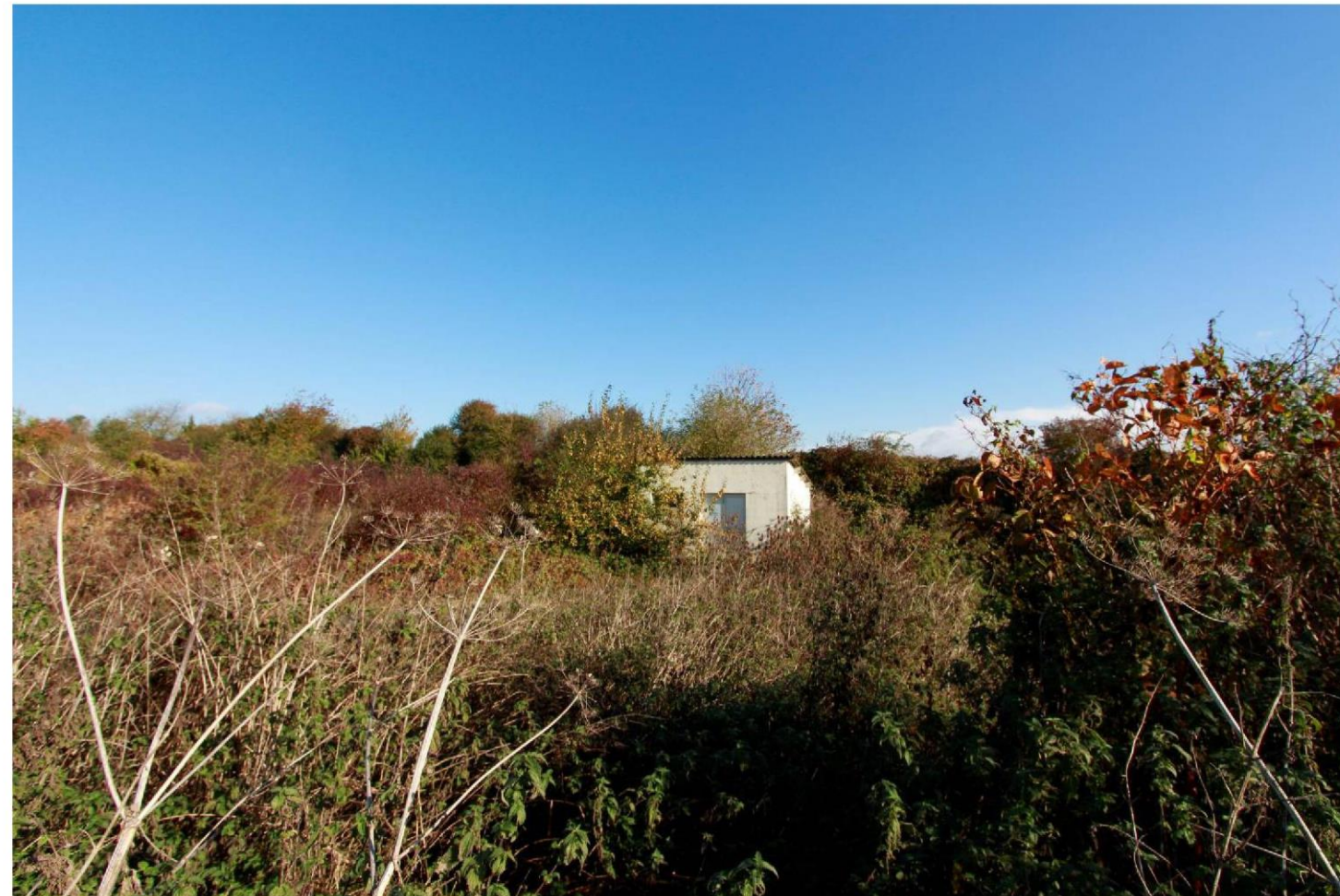
- Vue T : Vers l'Est - Depuis la voie communale n°304 de Flaucourt à Berny-en-Santerre Vue d'un local technique existant
